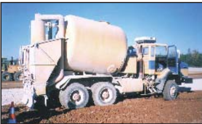
Fig. 8 - Extendido de la cal.
