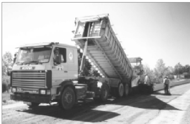
Foto 7. Extendido de mezcla bituminosa en caliente.
