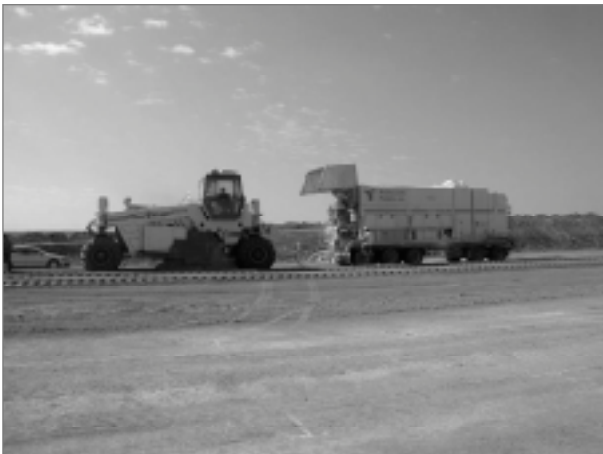
Foto 3. Ejecución de estabilización por vía húmeda.
