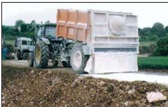
Fig. 12. Extendido de la cal.
