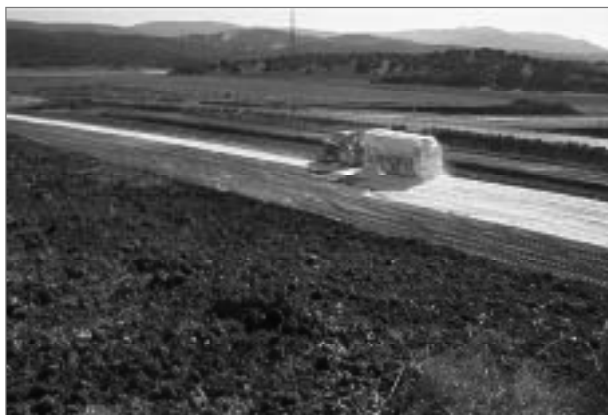
Foto 5. Extendido de la cal por vía seca.
