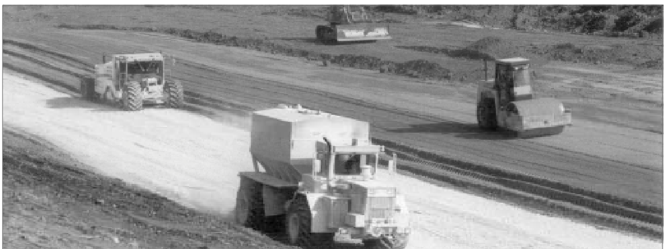
Foto 1. Obra de estabilización de suelos.
