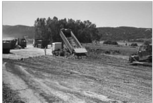
Foto 4. Preparación y extendido de los suelos a la Autovía A-381 "Jerez - Los Barrios".
