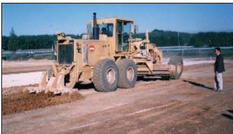
Fig. 10. Escarificación del suelo
