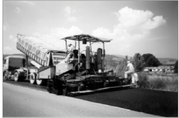
Foto 8. Extendido de mezcla bituminosa en caliente (MBC).
