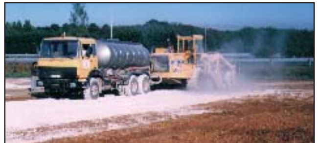
Fig. 13. Regado y mezclado del suelo con la cal.
