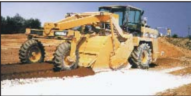
Fig. 9 - Mezclado del suelo y la cal.
