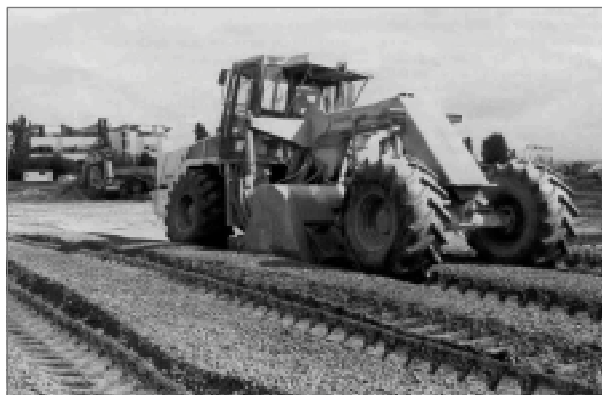
Foto 6. Extendido de la cal por vía seca.
